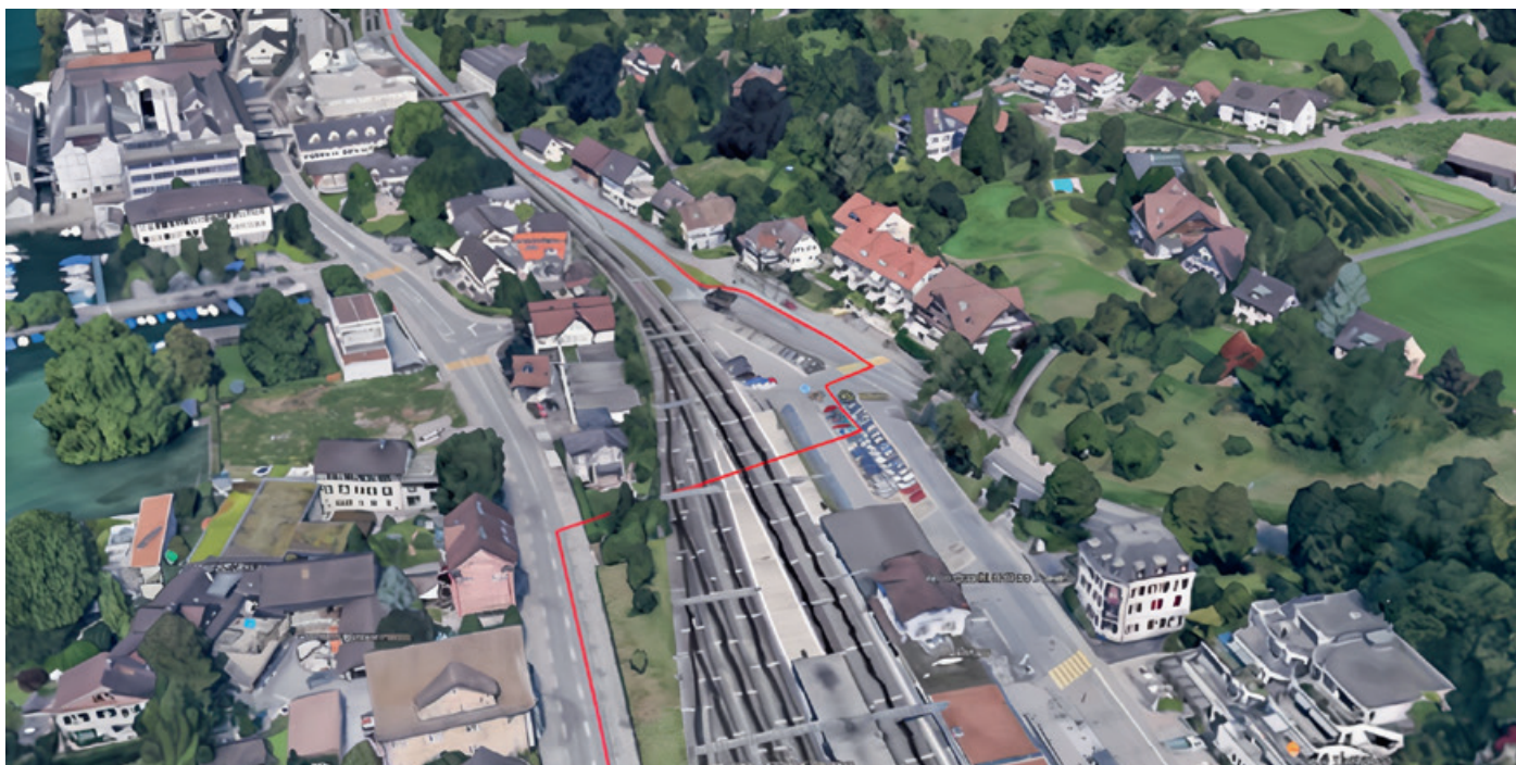
Abbildung 6: Luftaufnahme: Gleisunterquerung Bahnhof Uetikon Druckleitung im Pressbohrverfahren
