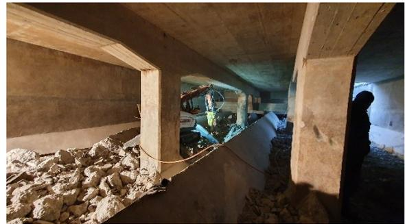
Abbildung 10: Sehr aufwendiger Betonabbruch.
