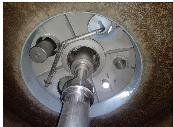
Abbildung 11: Verankerung Welle Rührwerk in Gashaube.
